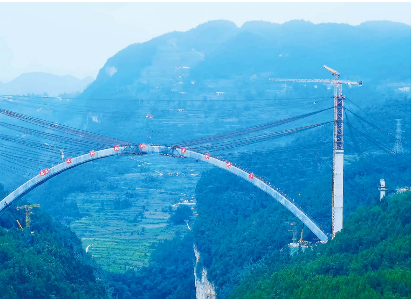
古金高速水落河特大桥
