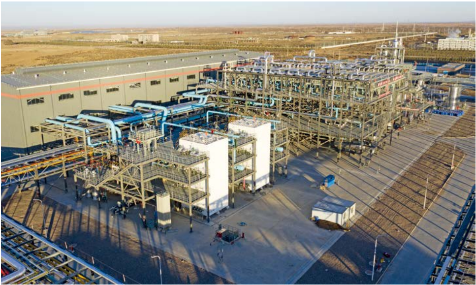
蜀道装备内蒙古雅海 300x 10Nmd 天然气制 LNG 装置
