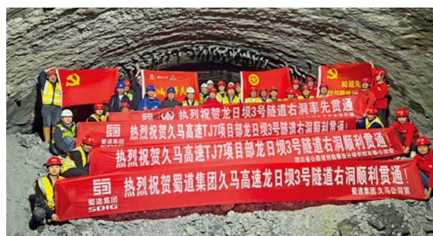
7月17日 久马高速龙日坝3号隧道右洞顺利贯通。
