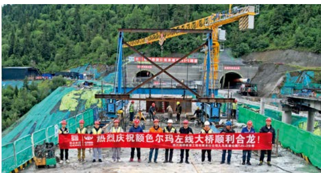
7月26日 久马高速公路全线首座刚构桥顺利合龙。
