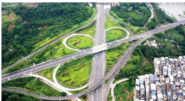
7月5日 成乐高速扩容项目绵竹至辜李坝段全面建成。
