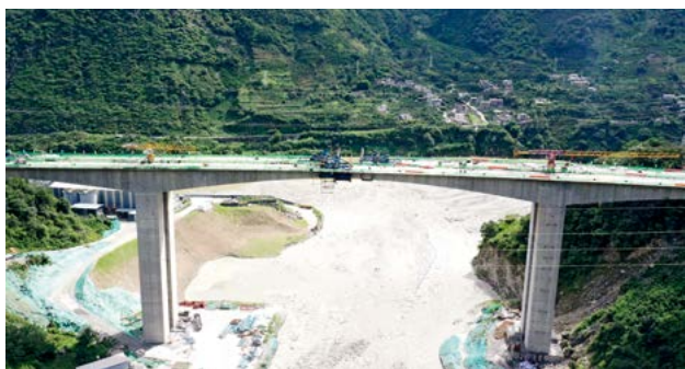
7月28日 泸石高速公路首座连续性刚构桥梁金光特大桥顺利合龙。
