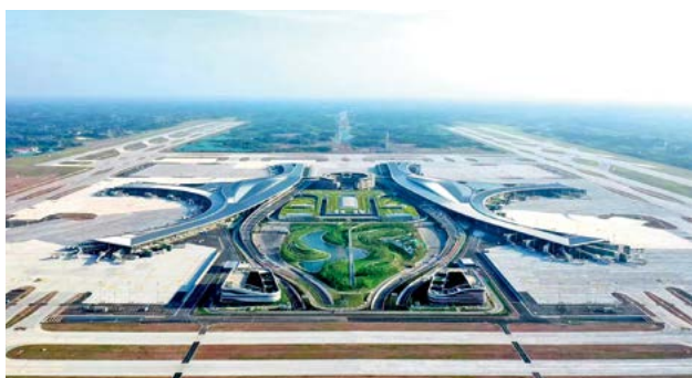
7月24日 成宜高铁天府机场站站房装修主体工程完工。
