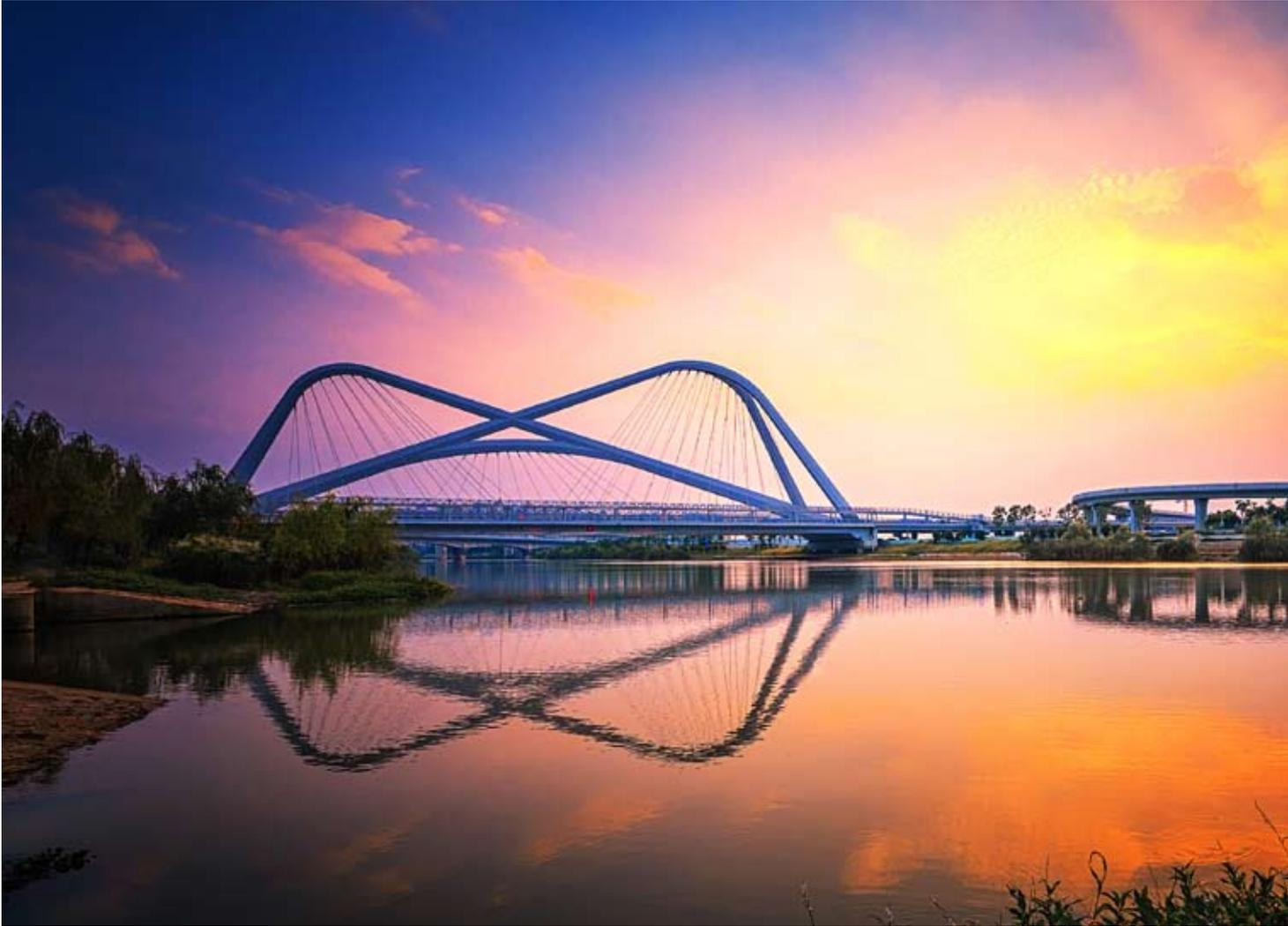
影响，在确保安全、规范的前提下，不断优化设计，为施工创造了有利的条件。在设计总体方案基本稳定时，参建各方也同步跟进，根据现场各种条件，进行施工方案的研究和比选，最终确定了“利用汛期完成钢箱梁陆上运输和支架上拼装工作，利用一个枯水期完成水上支架搭设、钢箱梁整体顶推就位、钢箱拱节段水上运输安装并最终成桥”的总体方案。
