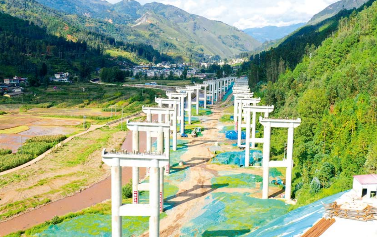
德会高速益门大桥
