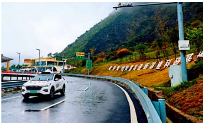
都汶高速龙池段智慧高速新基建科研基地
