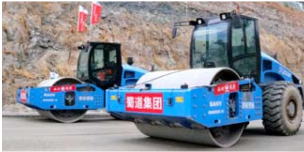
镇广路面摊压
