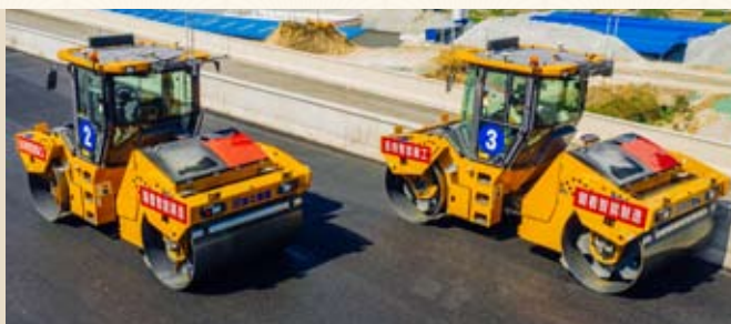
四川路桥沥青路面施工
