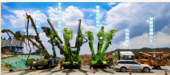
自动化、智能化施工装备
